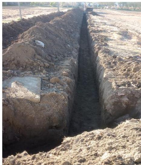
Figura 2 – Abertura de valas para a condutas principais do sistema de rega
