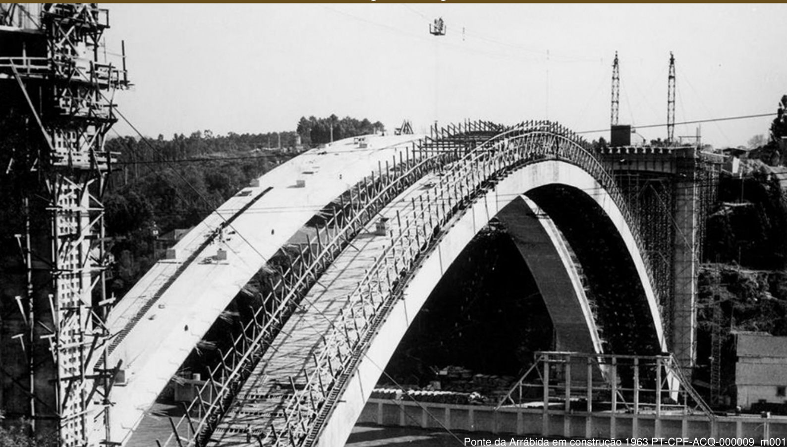
Ponte da Arrábida em construção 1963 PT-CPF-ACQ-000009 m001
